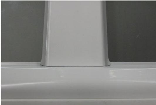
2. Vorab sollte die Sprossenlänge getestet werden. Sie sollte an beiden Enden Luft aufweisen. Sollte dies nicht so sein, muss die Sprosse nachgeschnitten werden.
